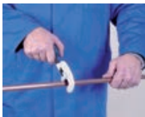
1. Corte de tubo 1. Cortar o tubo
