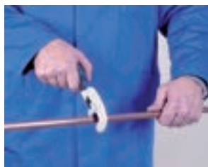
1. Corte de tubo 1. Cortar o tubo
