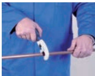
1. Corte de tubo 1. Cortar o tubo
