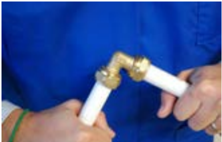
5. Montaje finalizado 5. Montagem terminado
